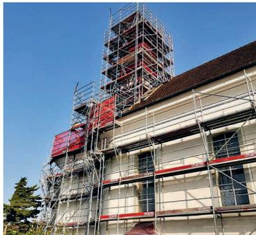
Unterdessen sind die Arbeiten in vollem Gange. Im Moment sind vor allem die Maler, Restauratoren und Holzfachmänner am Werk. Im Hintergrund werden auch die Turmkugel, die Ziffern und Zeiger der Uhr bearbeitet und neu vergoldet. Bereits leuchten der Turm und die Vordächer wieder strahlend rot hinter dem Gerüst hervor.
